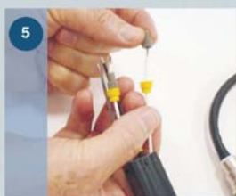
5 Zasuňte vodiče do šedých spojek.
