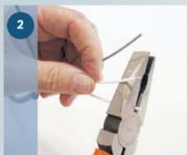
2 Odizolujte vodiče.
