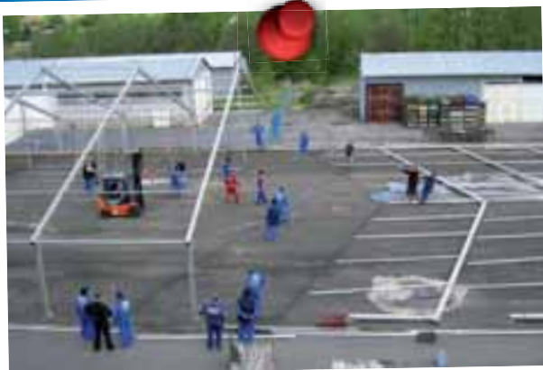
Stavba obřího party stanu
